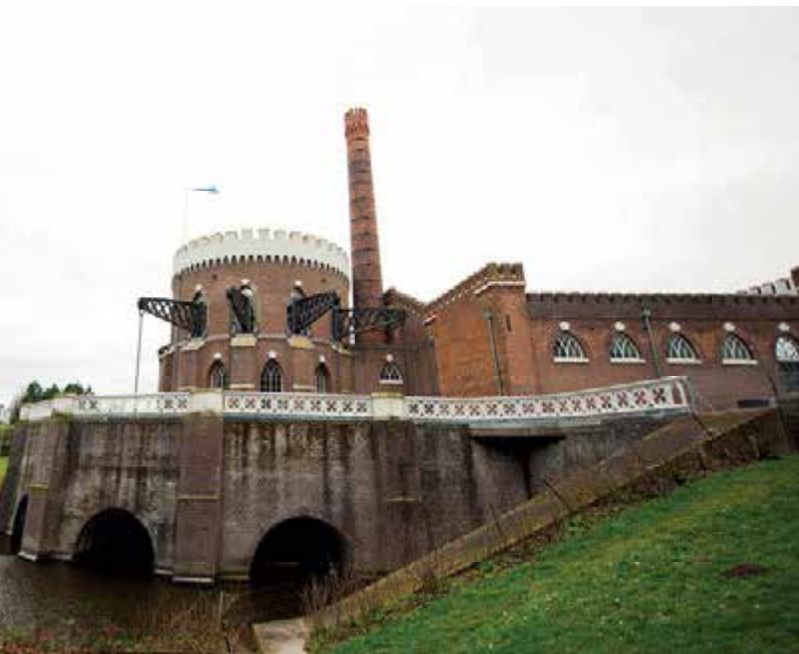
La estación de bombeo de Cruquius (1849), la máquina de vapor más grande del mundo. MINKE FABER
